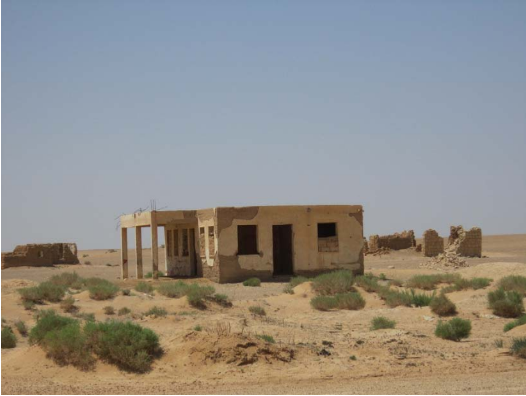
(الصورة ٤): العيادة الصحية القديمة في الجفر ( تصوير: الباحث)
