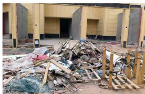
الشكل (5): مثال على مخلفات البناء بعد مرحلة التنفيذ الشكل (6): الية إعادة تدوير وتصنيع مخلفات مواد البناء
